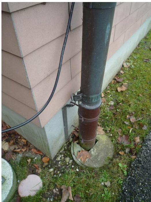
Beispiel Dachwasserfallstrang als Ableitung
